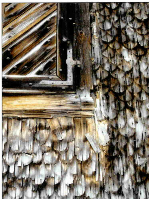
Detail Fassade (Foto H. Sumser).
