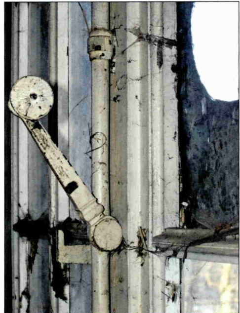
Detail Fenster mit Beschlag (Foto H. Sumser).
