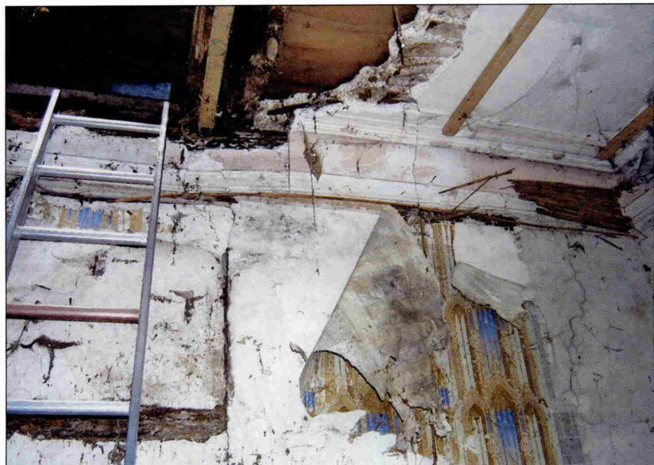
Innenraum, Deckenzone mit Tapetenrest (Foto H. Sumser).
