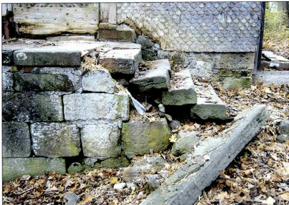
Nordfassade, Treppenaufgang rechts (Foto H. Sumser).
